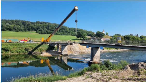
Abb. 1: Das Foto zeigt die Bauarbeiten an der alten Donaubrücke in Schäfstall mit dem Rückbau der Überbauplatte. Das mittlere Segment ist bereits teilweise ausgehoben.
