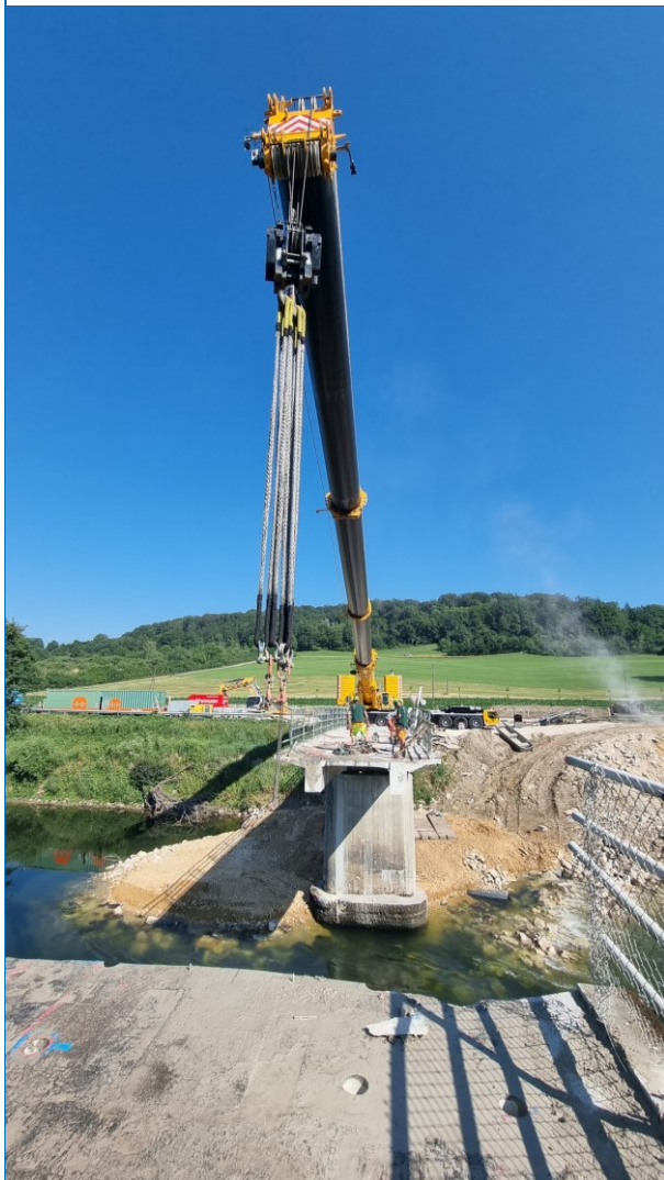
Abb. 2: Das Foto zeigt die Bauarbeiten an der alten Donaubrücke in Schäfstall mit dem Rückbau der Überbauplatte. Das mittlere Segment ist bereits teilweise ausgehoben. Die Vorbereitungen für den weiteren Rückbau laufen.
