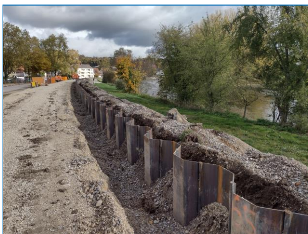
Abb. 3: Das Foto zeigt die Spundwand im Deich an dem Festplatz in Donauwörth. Die Bauarbeiten sind inzwischen abgeschlossen.
