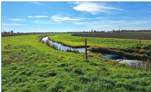
Abb. 2: Auf dem Foto ist der sanierte Egelseebachdeich zu sehen.
