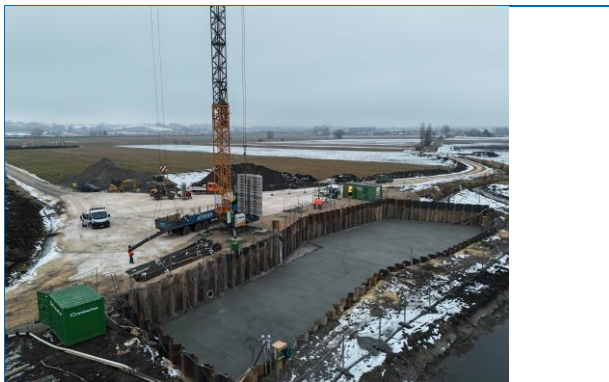
Abb. 4: „Das Foto zeigt den Blick auf die Baustelle des Hochwasserrückhaltebeckens neben dem Erlenbach am 05. Februar 2026 (Quelle: Was- serwirtschaftsamt Donau- wörth)“.
