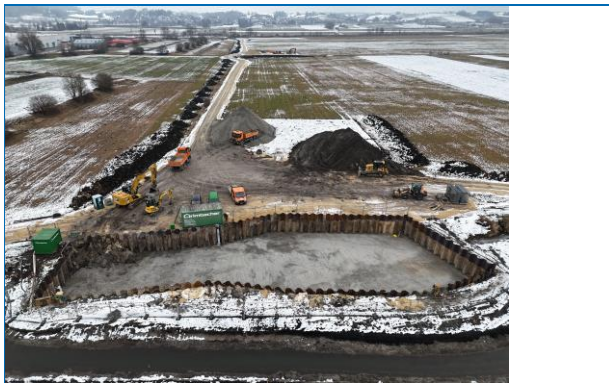
Abb. 3: „Das Foto zeigt den Blick auf die Baustelle des Hochwasserrückhaltebeckens am 02. Februar 2026 (Quelle: Wasserwirtschaftsamt Do- nauwörth)“.
