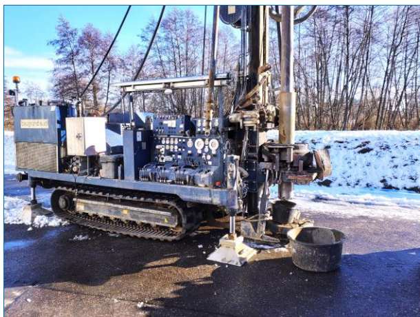
Abb. 1: Das Foto zeigt ein Bohrgerät für die Baugrunderkundung vor dem Deich in Buttenwiesen.
