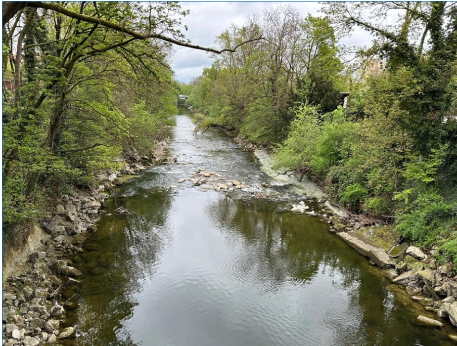
Abb. 1: Blick auf die Wertach nördlich vom Drentwettsteg. Rechtsseitig mittig ist durch die Eintiefung herauskommender heller Flinz zu sehen. Beidseitig sind nachrutschende Böschungssteine zu erkennen. Die Eintiefungen und Böschungen müssen gesichert werden.
