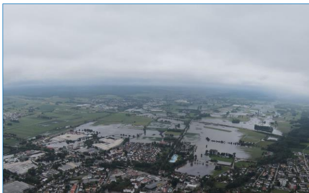
Abb. 3: „Das Foto zeigt den Blick auf den Bereich des Hochwasserrückhaltebeckens beim Hochwasser in Juni 2024 (Quelle: Stadt Burgau)“.
