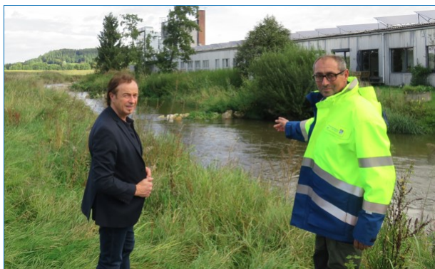
Abb. 1: Herbert Vogl (rechts) von der Flussmeisterstelle Augsburg erklärt Bürgermeister Bernhard Uhl (links) die vom Wasserwirtschaftsamt eingebauten strömunglenkenden Buhnen am Ostufer der Zusam bei Wörleschwang (Foto: Markt Zusmarshausen)
