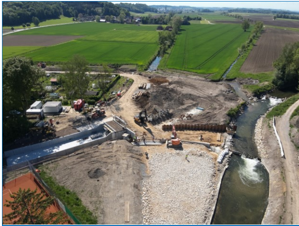
Abb. 3: Das Foto zeigt die Baustelle für den Hochwasserschutz Thannhausen im Mai 2025
