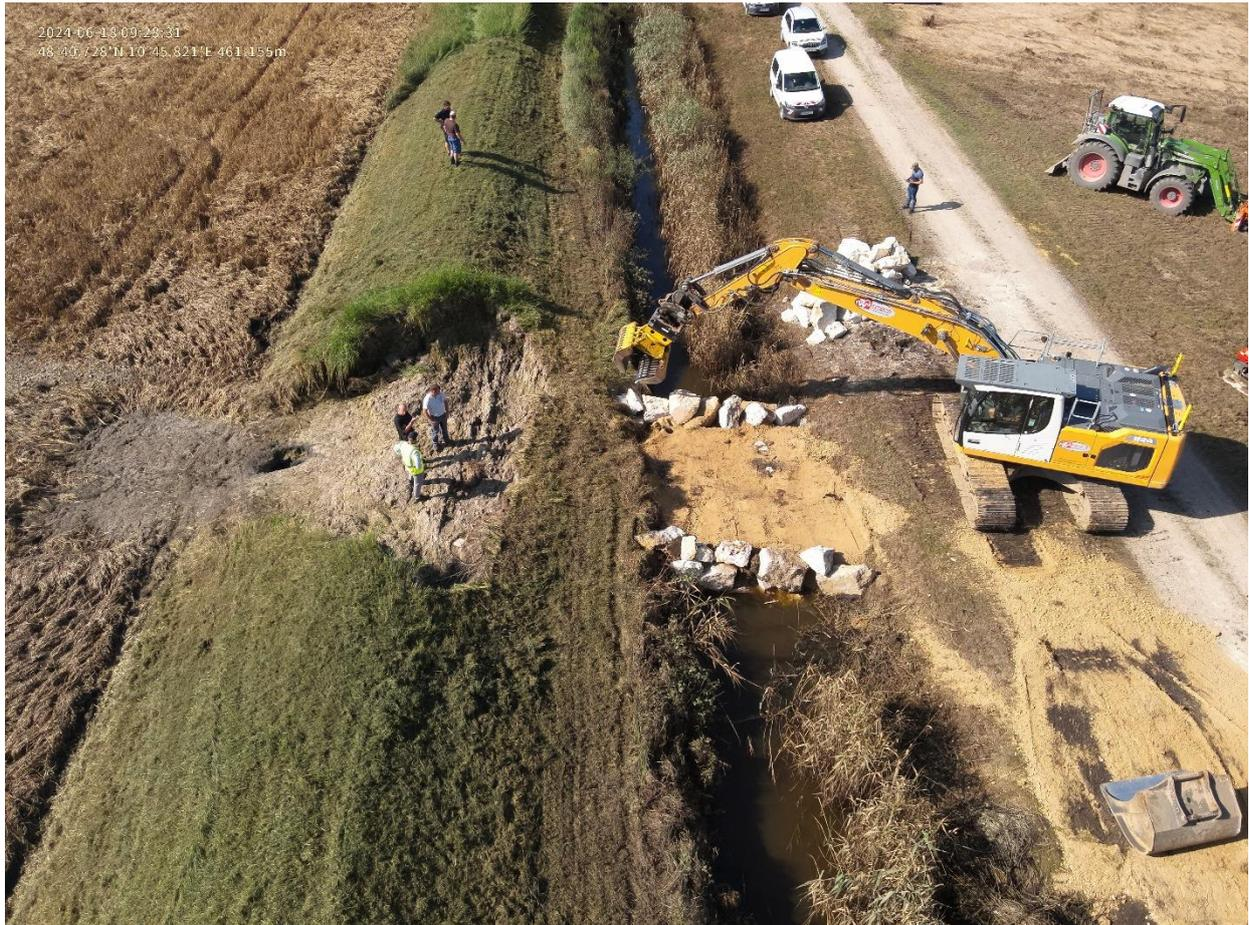
**Abbildung 27: Instandsetzung Deichbruch an der Zusam (Biberröhre) – Behebung unmittelbar nach dem Hochwasser**
