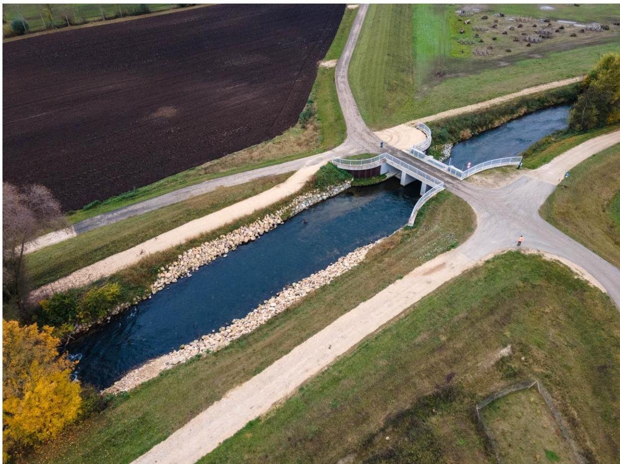
**Abbildung 26: Wiederhergestellte Ufersicherung am Drosselbauwerk, Hochwasserschutz Thannhausen, Mindel**
