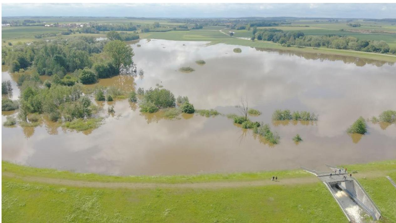
**Abbildung 17: Der Abfluss am HRB Putzmühle wurde auf ein Minimum gedrosselt**
