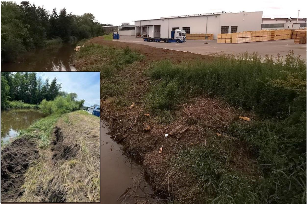
Abbildung 11: Zusam, Deich in Buttenwiesen bei der Firma Romakowski – Rutschungen an der Deichböschung wasserseitig und wiederhergestellter Deich
