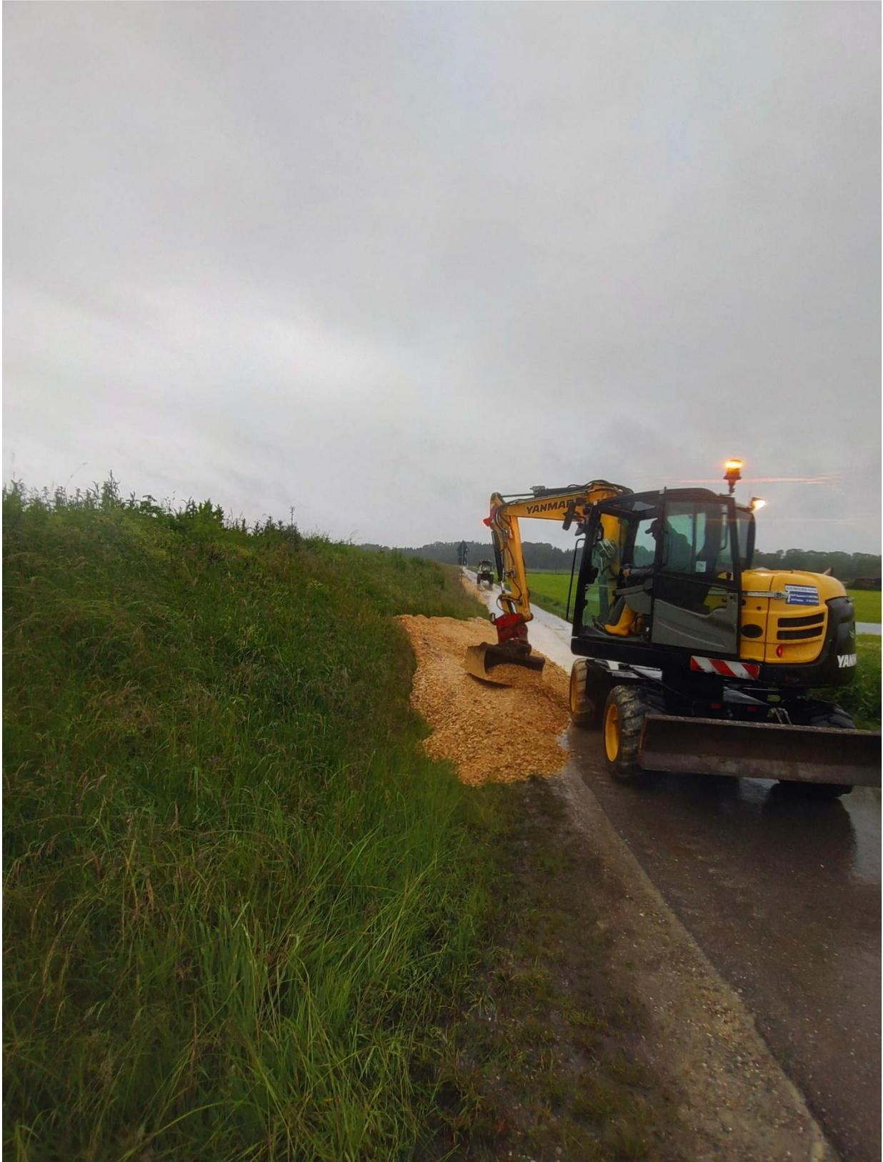
**Abbildung 3: Sicherungsmaßnahmen am Damm des Rückhaltebeckens Balzhausen während des Hochwassers**
