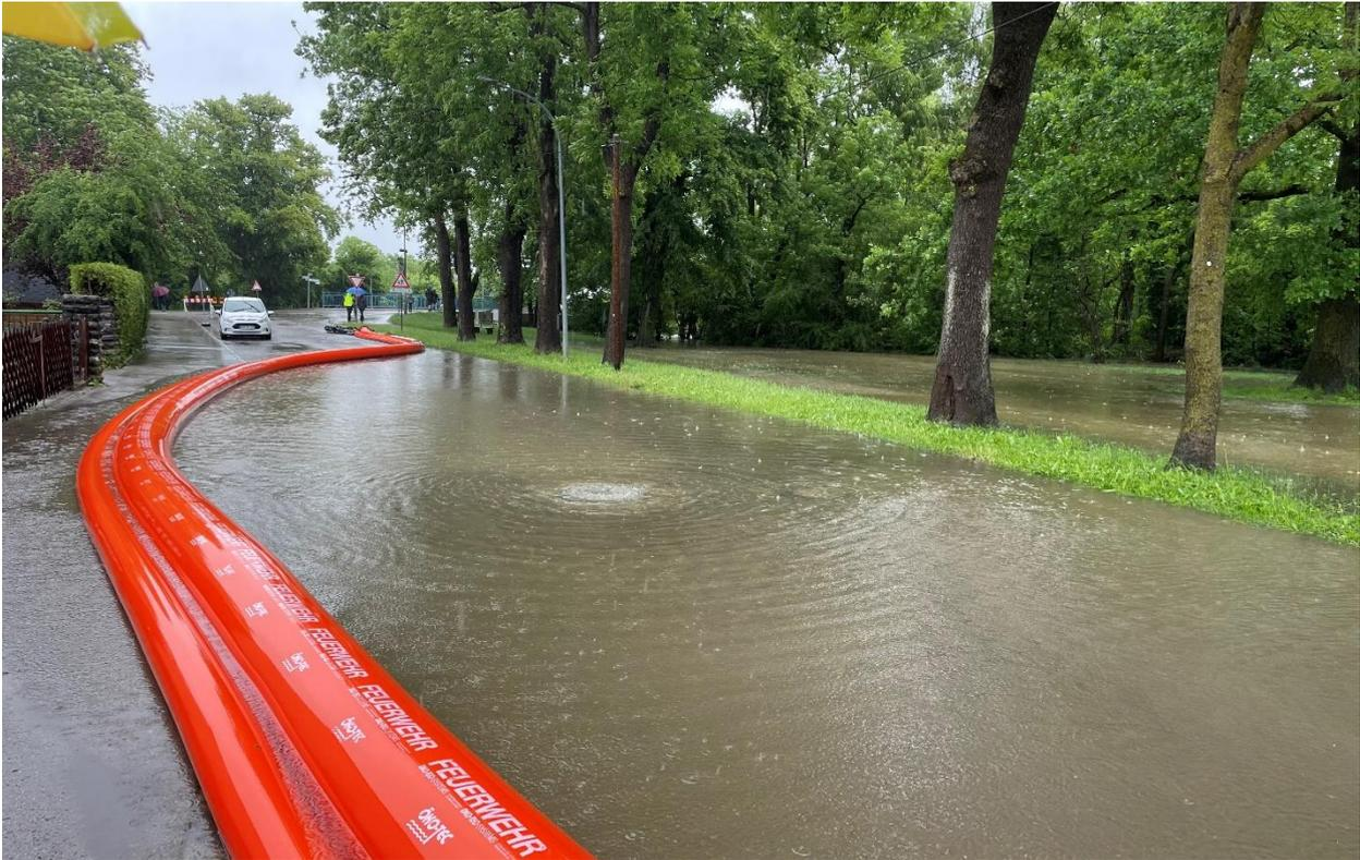
Abbildung 32: Schlauchdeich in Mering zur Rückstausicherung aus einem Kanal
