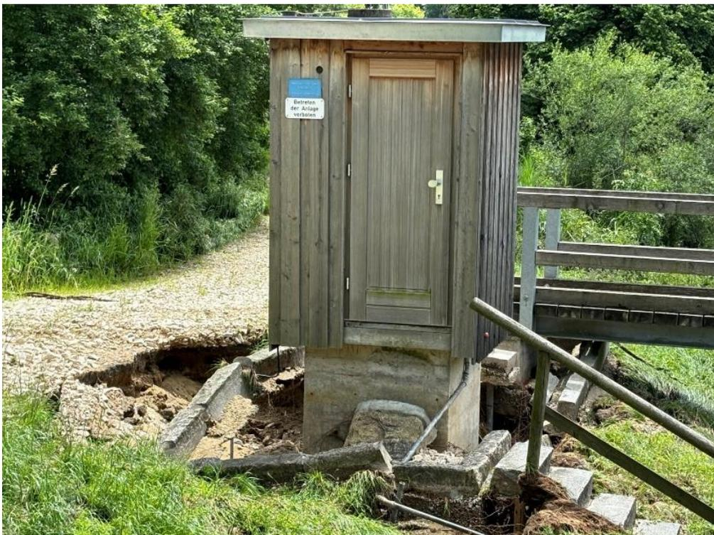
Abbildung 37 - Pegel Blumenthal – Der Pegel ist im Hochwasser stark beschädigt worden
