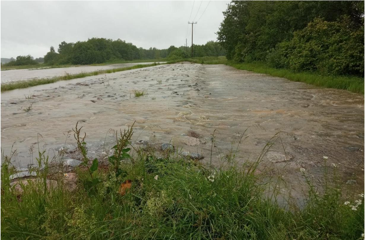
Abbildung 26: Brunnenbach, Wasser läuft über die Hochwasserentlastung des HRB Mörslingen
