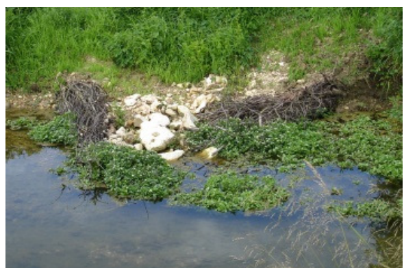
Abbildung 10 Beispiel für den Einbau von Astbündeln kombiniert mit Wasserbausteinen im Bereich Göllingen
