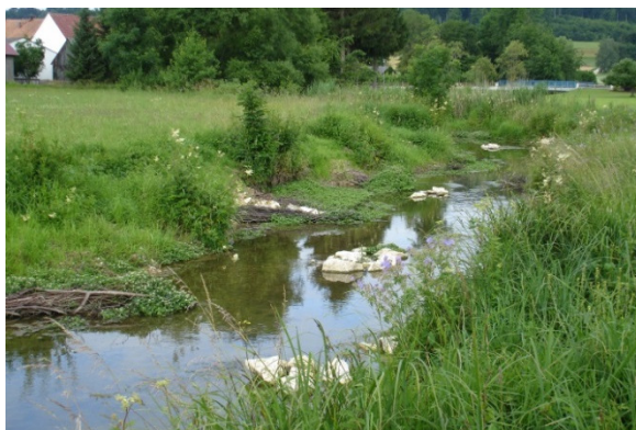
Abbildung 10 Beispiel für den Einbau von Astbündeln kombiniert mit Wasserbausteinen im Bereich Göllingen
