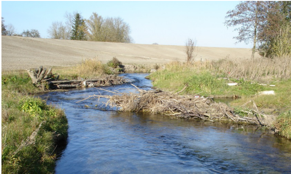
Abbildung 2 Beispiel für den Einbau von Leitwerken aus Holz
