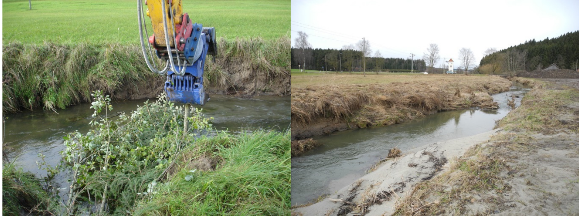
Abbildung 6 Beispiel für den Einbau eines Leitwerkes aus Totholz (Astmaterial, Fichte) und Sandanlandung an derselben Stelle nach 3-4 Jahren. Die Sohle ist in diesem Bereich von der Sandauflage befreit und kiesig überspült.
