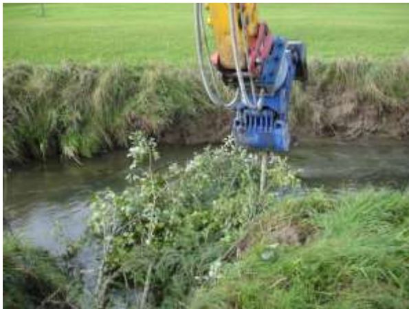
Abb. 6: Beispiel für den Einbau eines Leitwerkes aus Totholz (Astmaterial, Fichte) und Sandanlandung an derselben Stelle nach 3-4 Jahren. Die Sohle ist in diesem Bereich von der Sandauflage befreit und kiesig überspült.
