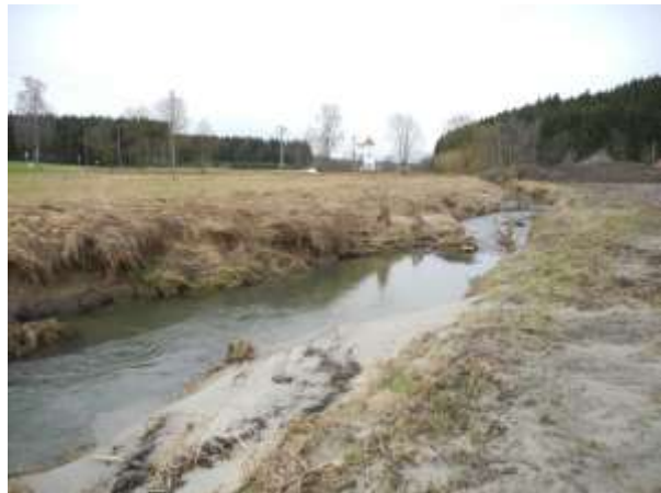
Abb. 6: Beispiel für den Einbau eines Leitwerkes aus Totholz (Astmaterial, Fichte) und Sandanlandung an derselben Stelle nach 3-4 Jahren. Die Sohle ist in diesem Bereich von der Sandauflage befreit und kiesig überspült.
