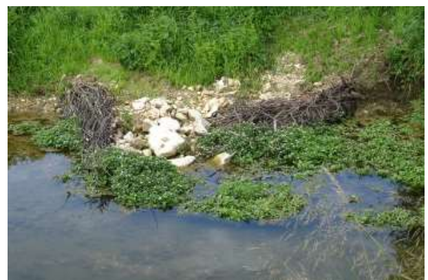
Abb. 10: Beispiel für den Einbau von Astbündeln kombiniert mit Wasserbausteinen im Bereich Göllingen
