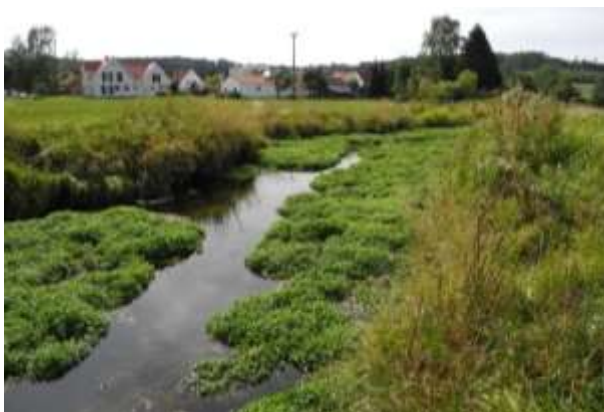
Abb. 11: Entwicklung nach drei Jahren: Im vorher überbreiten Bachbett hat sich eine Niedrigwasserrinne gebildet
