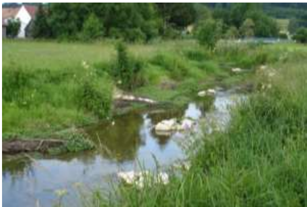
Abb. 10: Beispiel für den Einbau von Astbündeln kombiniert mit Wasserbausteinen im Bereich Göllingen
