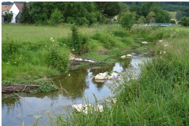
Abb. 10: Beispiel für den Einbau von Astbündeln kombiniert mit Wasserbausteinen
