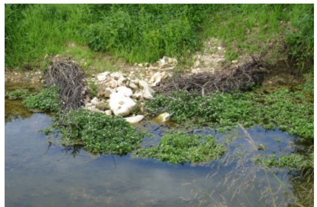
Abb. 10: Beispiel für den Einbau von Astbündeln kombiniert mit Wasserbausteinen
