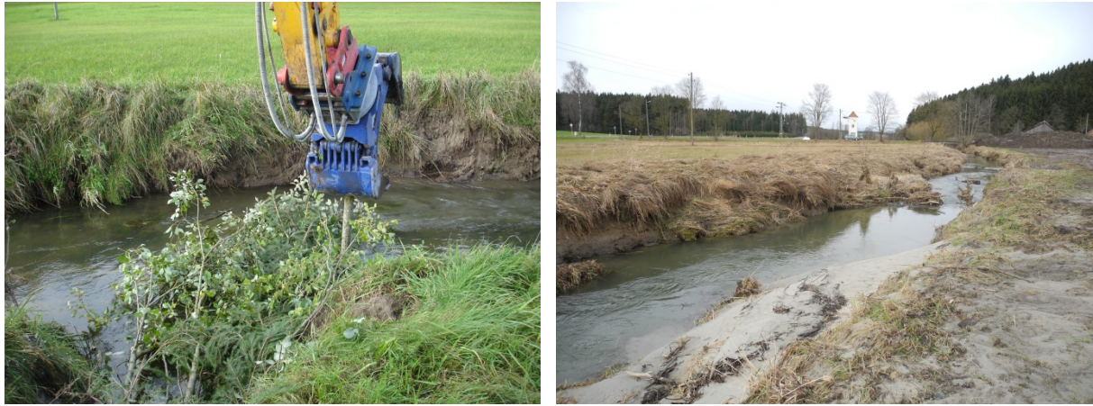
Abb. 6: Beispiel für den Einbau eines Leitwerkes aus Totholz (Astmaterial, Fichte) und Sandanlandung an derselben Stelle nach 3-4 Jahren. Die Sohle ist in diesem Bereich von der Sandauflage befreit und kiesig überspült.
