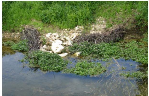
Abb. 10: Beispiel für den Einbau von Astbündeln kombiniert mit Wasserbausteinen
