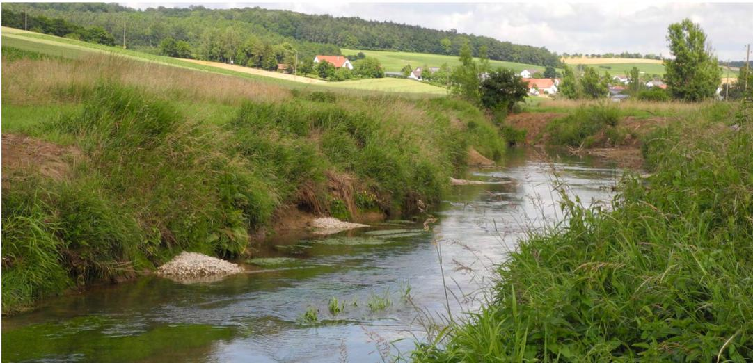
*Abbildung 6: Die Kessel unterhalb der Bergmühle in Unterbissingen (Fkm 14,4) mit bereits umgesetzter Maßnahme (Einbau von Buhnen zur Verbesserung der Strömungsvarianz)*
