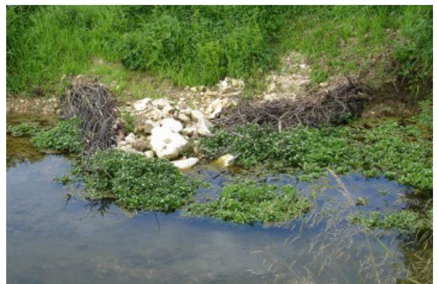
Abb. 10 und 11: Beispiel für den Einbau von Astbündeln kombiniert mit Wasserbausteinen im Bereich Göllingen
