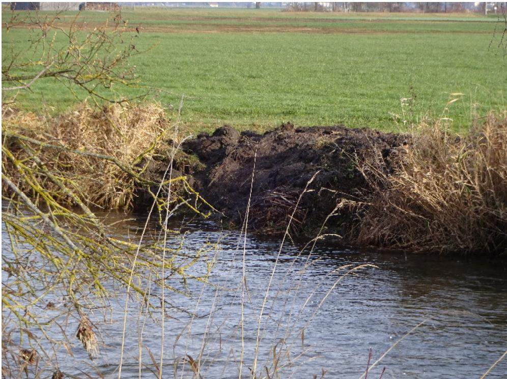
*Abb. 5: Verfüllung eines Uferanbruchs zur Erhaltung der landwirtschaftlichen Nutzfläche, hier mit ungeeignetem Material (Oberboden)*
