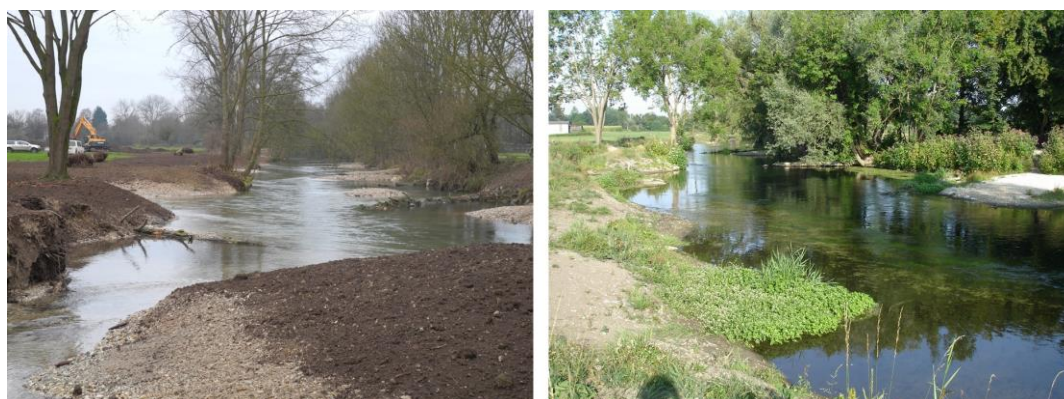
Abb. 1: Die Doppelabbildung zeigt eine vergleichbare Maßnahme an der Brenz. Auf dem linken Bild ist die Abflachung des Ufers mit neu angelegten Buhnen und Totholz kurz nach der Umsetzung zu sehen. Das rechte Bild zeigt die natürlich eingewachsene Uferböschung in den Folgejahren.
