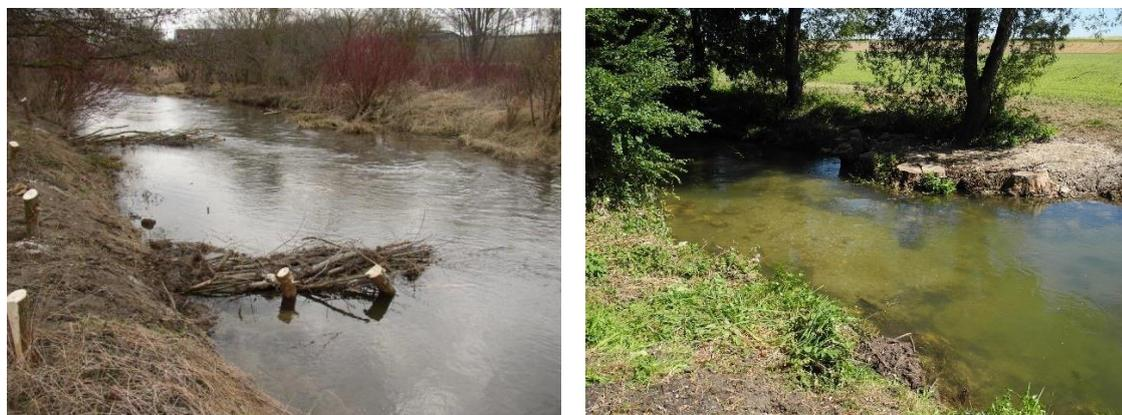
Abb. 1 Beispielhafte Maßnahmen Totholzeinbau Typ 71 bis 70.3
