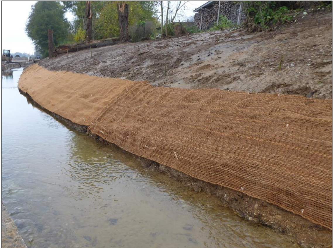
Abb. 12: Fixierung Oberboden an Gewässerböschung mittels Jutematte (Bild: TEAM 4)
