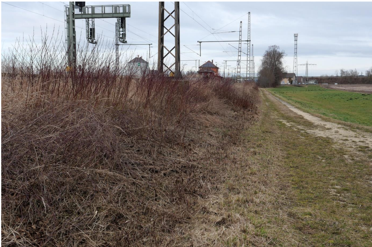
Abb. 12: Bahnböschung im Südabschnitt südlich des Bahnhofs Burgau. Entlang der Böschung und des Weges wird eine 0,8-1 m hohe Leitstruktur angebaut.
