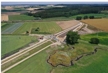
Blick von oben auf das Hochwasserrückhaltebecken Merching an der Steinach. Hier werden im Hochwasserfall bis zu 1,1 Mio. m 3 zurückgehalten, um so die Gemeinden Mering, Kissing und Friedberg vor Hochwasser zu schützen Quelle: WWA Donauwörth
