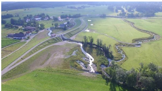
Das Hochwasserrückhaltebecken Eldern nach Fertigstellung, Quelle: WWA Kempten
