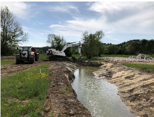
Bauarbeiten für die neue Flussschleife an der Schmutter Quelle: WWA DON, 2020
