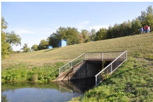
Durchlassbauwerk im Trenndeich
