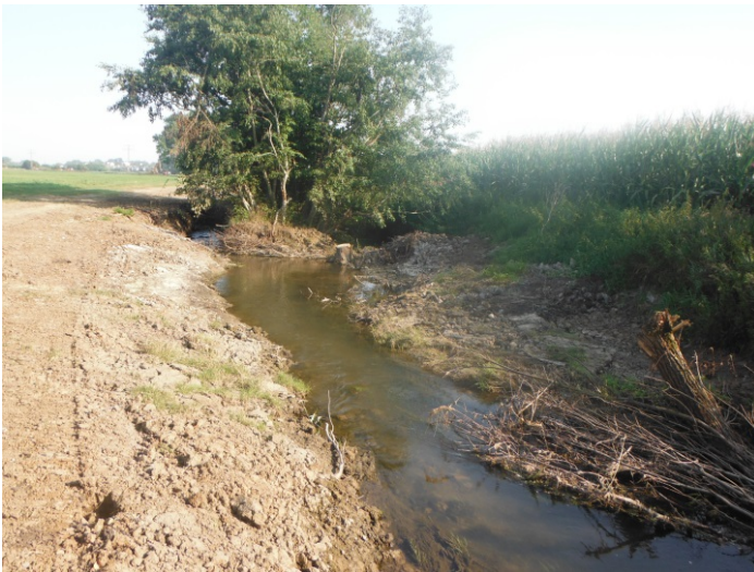
Gewässerbettmodellierung mit Einbringung von Totholz an der Steinach
