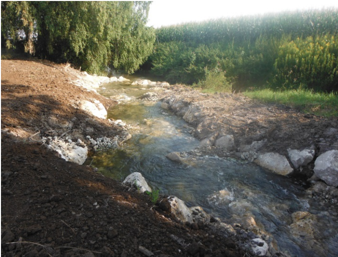
Umbau eines ehem. Absturzes an der Steinach
