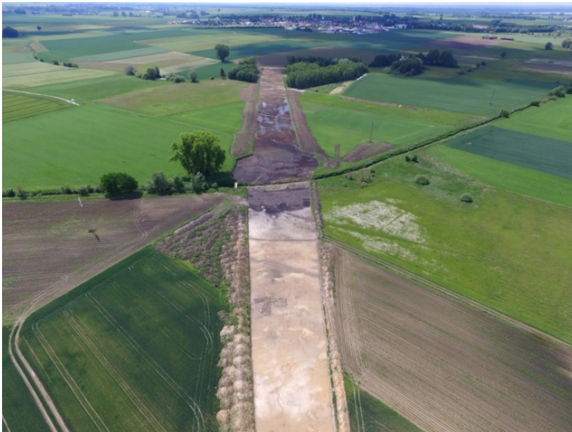
Luftbild Dammaufstandsfläche Mai 2018
