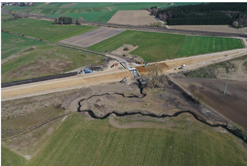
Dammbauwerk mit neuem Steinachlauf April 2020
