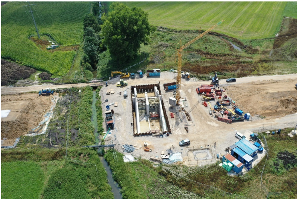
Baugrube Auslassbauwerk Aug. 2019
