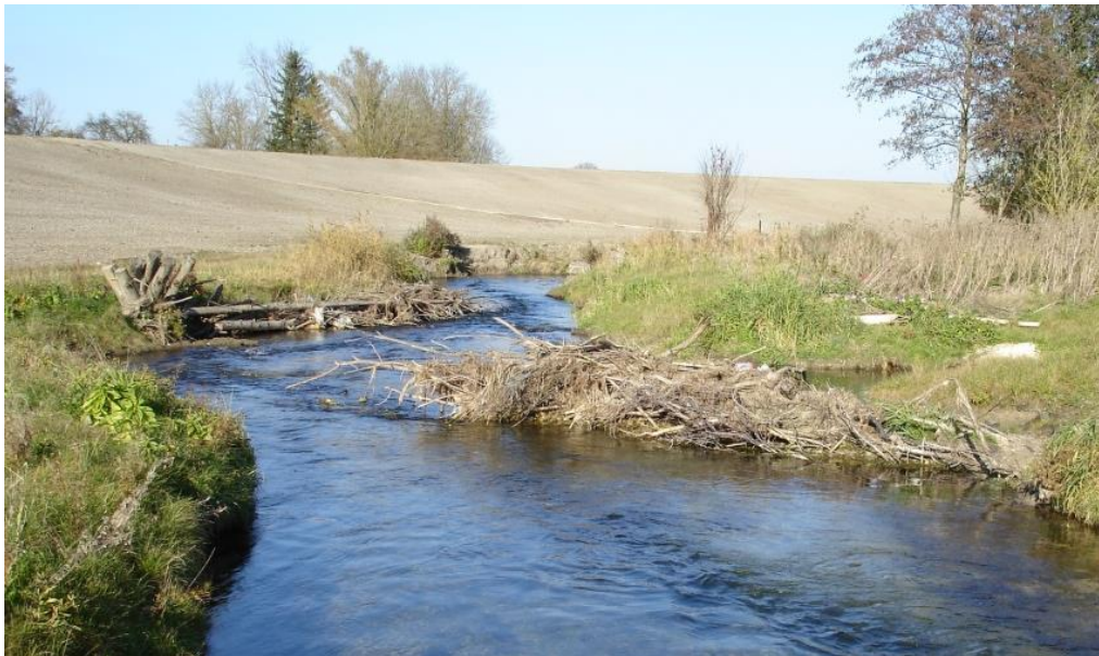
Abb. 2: Beispiel für den Einbau von Leitwerken aus Holz
