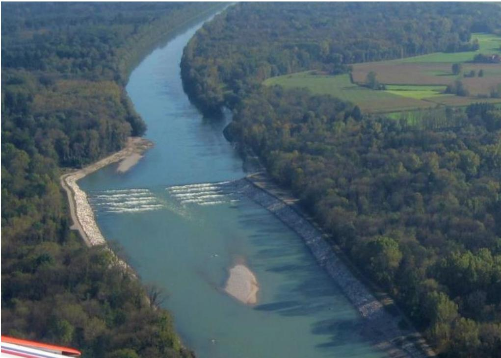
Abbildung 32: Aufgelöste Sohlrampe an der Salzach (Quelle Herr Schaufler,
