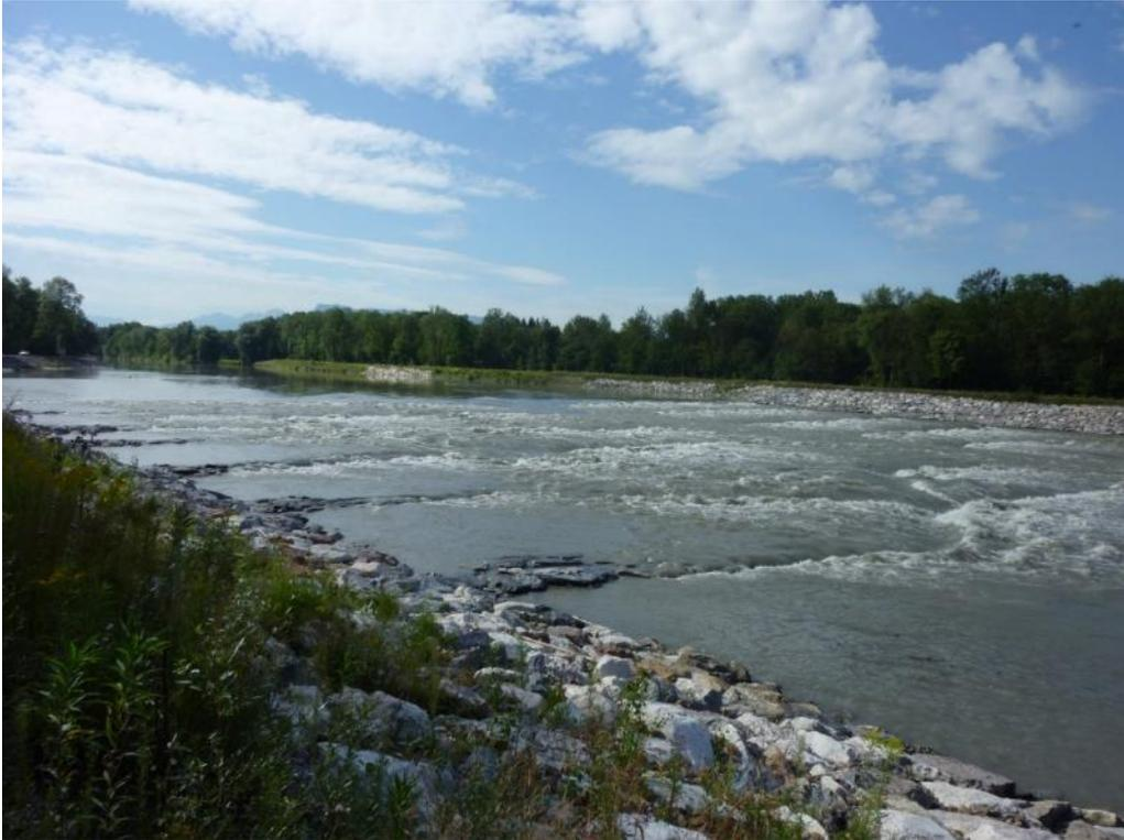
Abbildung 31: Aufgelöste Sohlrampe an der Salzach
