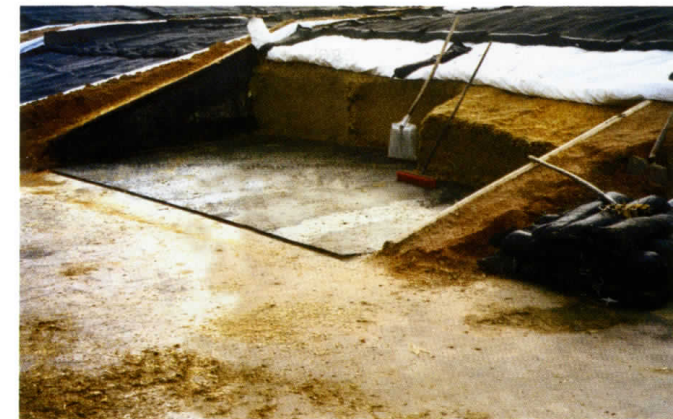
Silo beim Entleeren, Vorplatz besenrein
