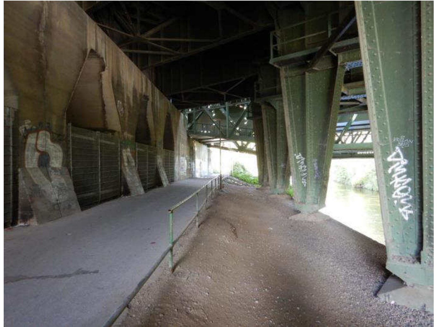
BCE 09/2020 (Fotostandort DB-Brücke)
