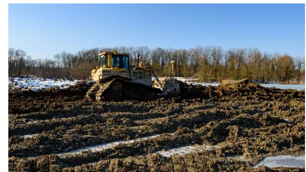
Bauphase - Beispiel Salzach (Foto: REVITAL)
